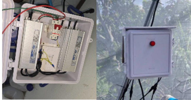
ภาพที่ 3.8 การติดตั้งระบบ
