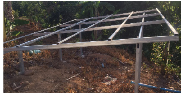
ภาพที่ 3 สร้างฐานวางโซล่าเซลล์
