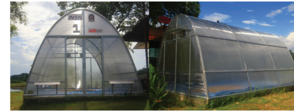
ภาพที่ 2 โรงอบแห้งพลังงานแสงอาทิตย์ ขนาด 4 x 6 x 3 เมตร
