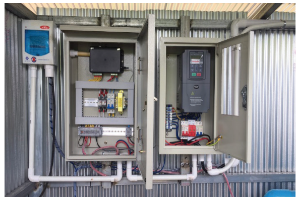
ภาพที่ 4 ตู้ควบคุมระบบการให้น้ำและชุดคอลโทล
