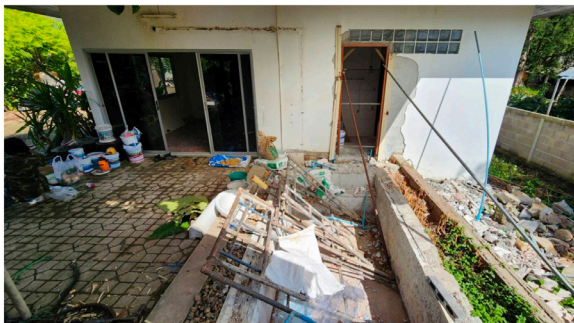
ภาพ ช่วงดำเนินการรื้อถอนสิ่งก่อสร้างเดิม และปรับพื้นที่
