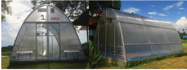
ภาพที่ 2 โรงอบแห้งพลังงานแสงอาทิตย์ ขนาด 4 x 6 x 3 เมตร
